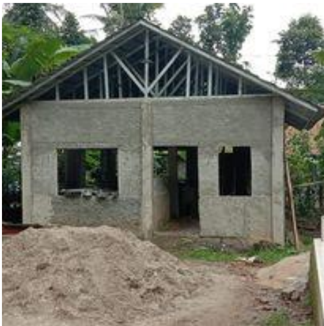
Pembangunan asrama guru
